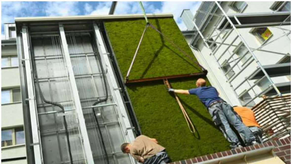
Abbildung 1: Aufbau und Installation mehrerer Moosmodule (Foto: Gartenheim)
