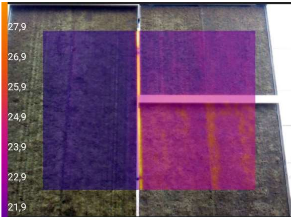
Bild 2-19: Wärmebild der Moosfassade An der Tiefenriede (AdT), Quelle: Bachelorarbeit Eike Lükker.
