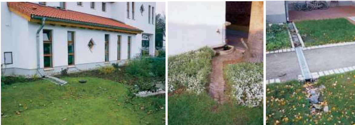
Bild 2-4: Oberirdische Zuleitung vom Fallrohr zu Versickerungsanlagen (Quelle: HMULV, 2007)
