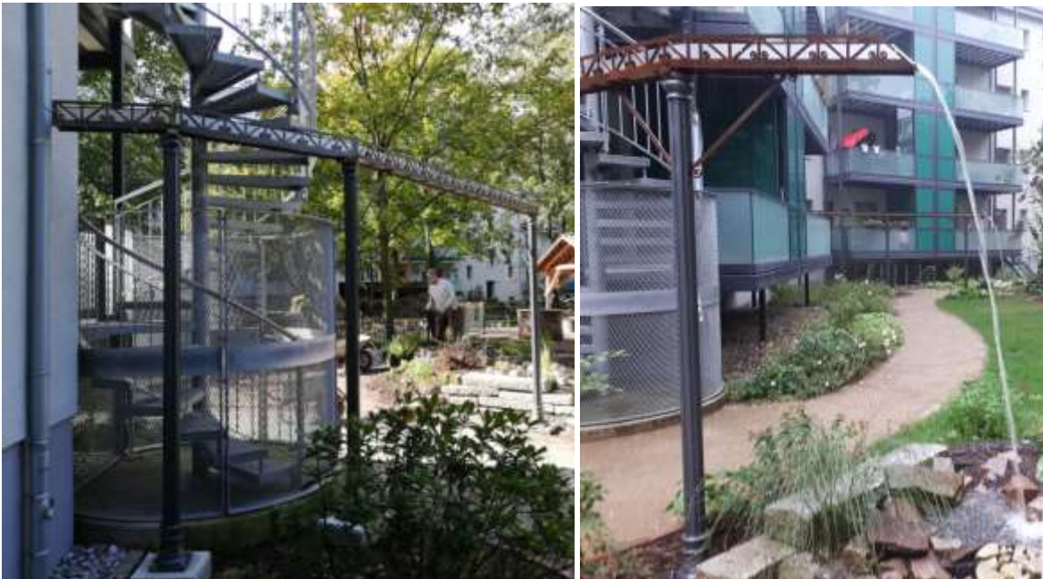
Bild 2-6: Oberirdische Zuleitung vom Fallrohr zu einem Teich mit Uferversickerung (Quelle: aqua-planer, ISAH)
