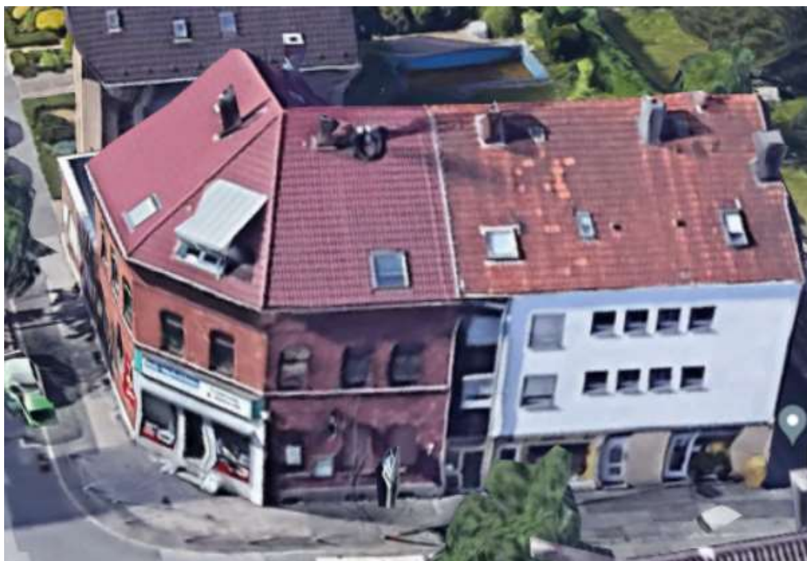
Bild A 4: Dacheindeckung aus geschuppten Dachziegeln (Google Earth 2022)
