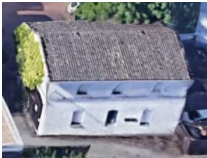
Bild A 3: Dacheindeckung aus Metallblechen (Google Earth 2022)
