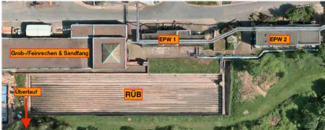
Abbildung 74: Luftaufnahme KA Hh - EPW, mech. Reinigung und RÜB ( https://www.google.de/maps , Stand 04.01.2021, eigene Erweiterung)
