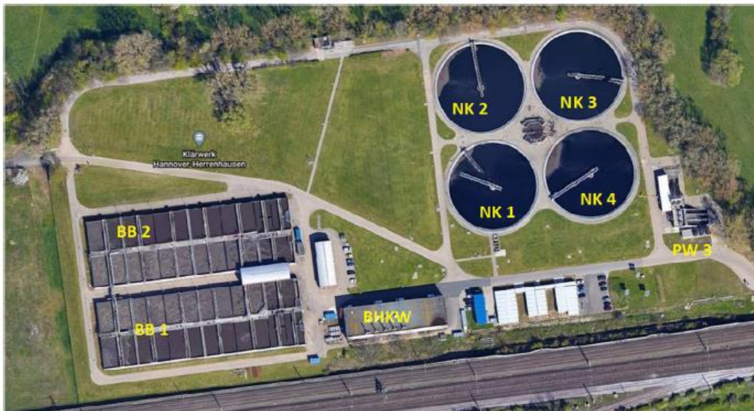
Abbildung 75: Luftaufnahme KA Hh - BB & NKB ( http://www.google.de/maps , Stand 28.01.2021, eigene Erweiterung)
