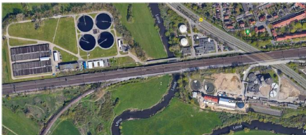
Abbildung 76: Luftaufnahme KA Hh (Gesamtüberblick) ( http://www.google.de/maps , Stand 28.01.2021)
