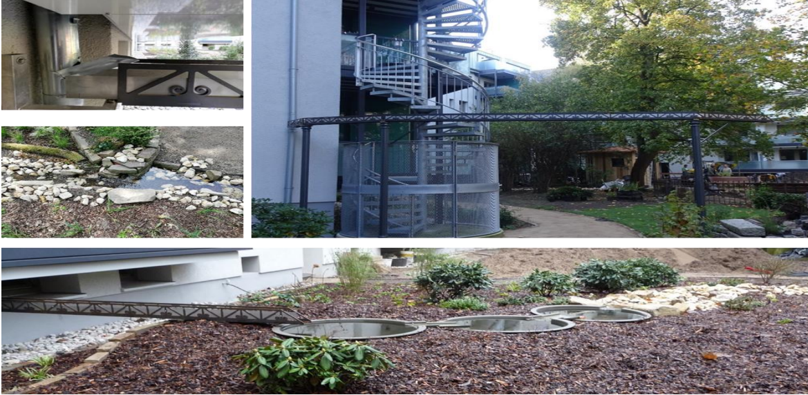
Abbildung 11: Zuleitung Niederschlagswasser von Dach zu Teich im Innenhof Südstadt. Bildquellen: ISAH
