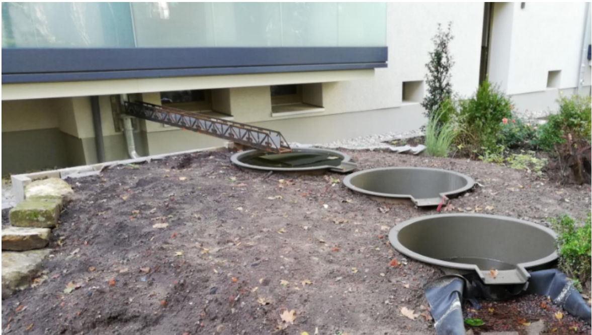
Abbildung 2: Zuleitung Niederschlagswasser von Dach im Westen zum Teich im Innenhof. Bildquellen: ISAH
