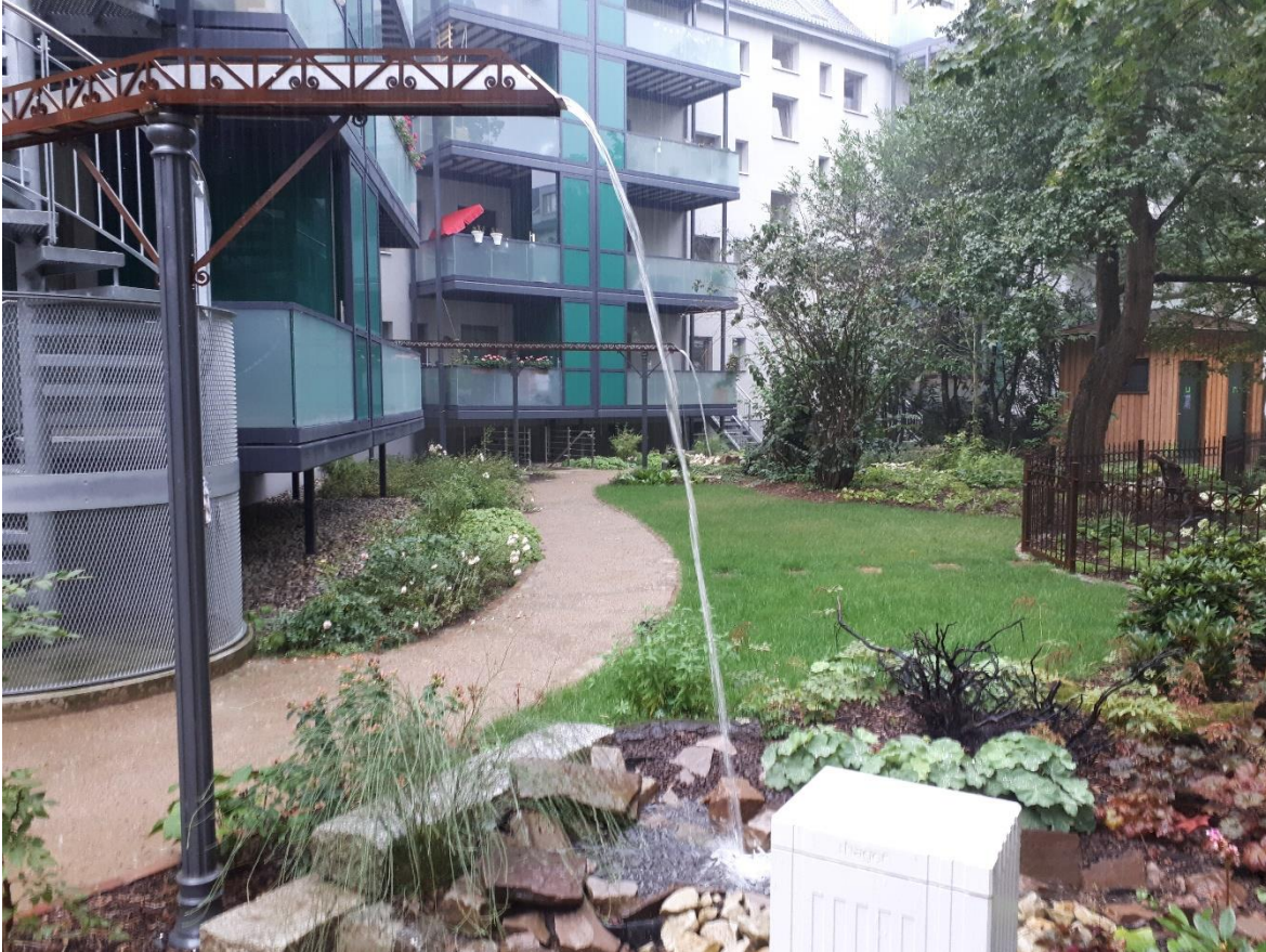
Abbildung 3: Zuleitung Niederschlagswasser von Dach im Osten zum Teich im Innenhof. Bildquellen: ISAH
